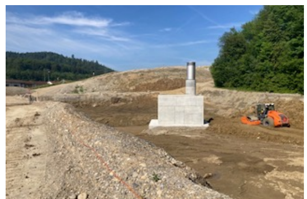
Abb. 5.8: Ertüchtigter Endschant Ost der Massnahme Süd mit neuem Ansaugkamin
