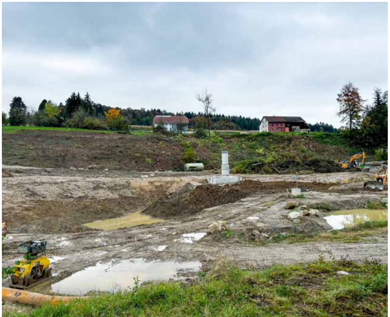
Abb. 5.3: Rodung des Rutschhangs an der Nordflanke des ehemaligen Deponiegeländes
